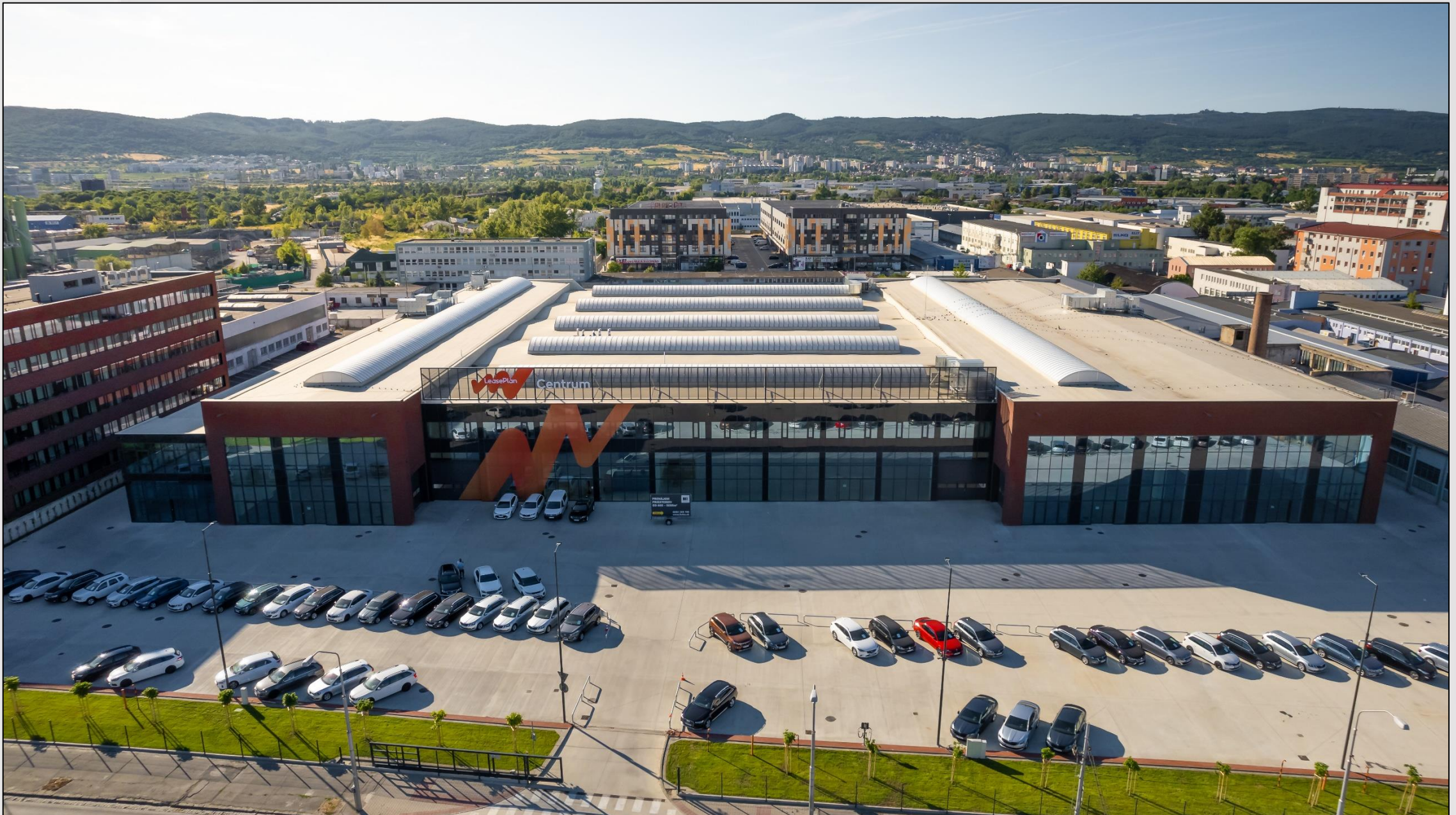
Pohľad od ulice Vajnorská
